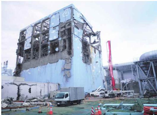
水素爆発により大きく損壊した福島第一原発4号機＝平成23年5月1日
